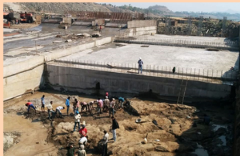
गुरुदेवर विवर का निर्माण, नर्मदा बांध के 12 किलोमीटर डाउनस्ट्रीम में एक मिलियन एकड़ फीट (एमएफएफ) पानी यानि नर्मदा बांध की क्षमता का चौथाई हिस्सा, संग्रहित करने के लिए किया जा रहा है। बिजली पैदा करने के लिए विवर से पानी वापस पंप किया जाएगा।
