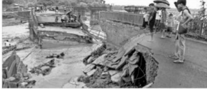
असम के बक्सा जिले के कुमरीकाटा में बाढ़ के कारण कंक्रीट पुल ढह गया।
