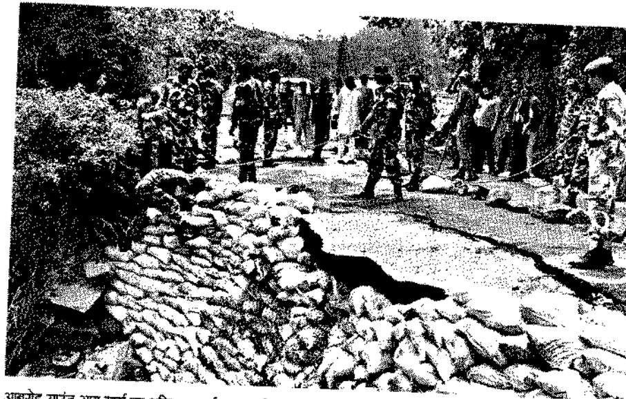
आबूरोड मार्ग पर क्षतिग्रस्त हुई सड़क को कंक्रीट की भरी बैरियों से पूरा करते सीआरपीएफ के जवान। पत्रिका
